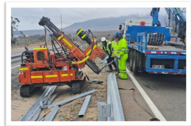
Foto 3: Ruta 5, Trabajos de cambio de barrera metálica, proyecto seguridad vial, tramo interurbano.
