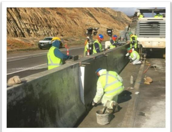
Foto 2: Ruta 5, km 244, fabricación barrera hormigón, tramo I, sector interurbano.
