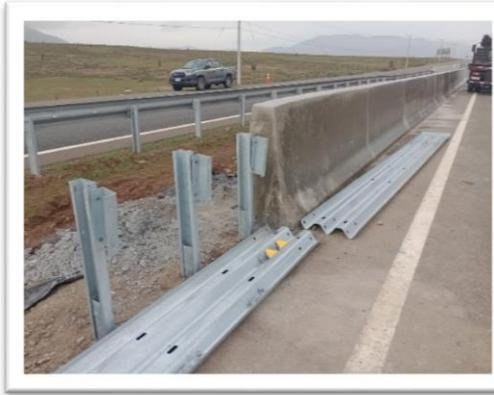
Foto 3: Revisión de empalmes entre barrera de hormigón y barrera metálica, sector interurbano.
