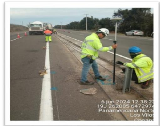
Foto 2: Ruta 5, Verificación topográfica instalación de barrera metálica, tramo I, sector interurbano.
