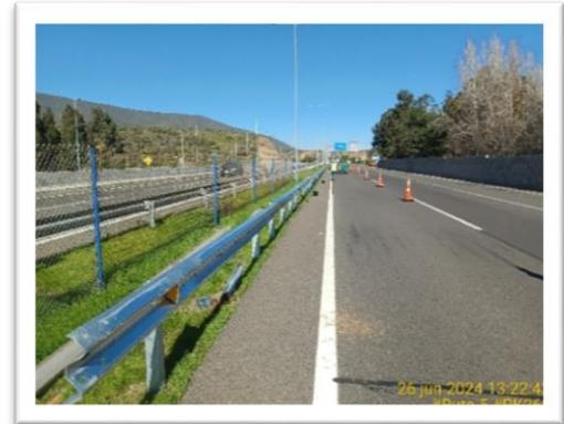
Foto 1: Ruta 5, km 260, Instalación barrera metálica tramo I, sector interurbano.
