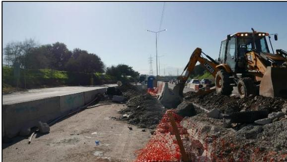
Foto 5: Trabajos de excavación para ejecución de fundaciones de pórticos de cobro (km 8)
