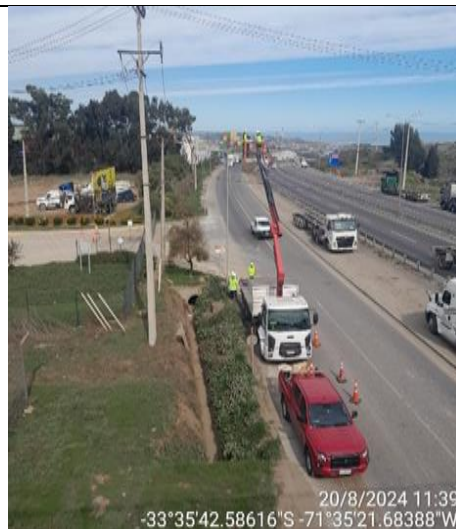
Mantenimiento Luminarias-NAPSA-km. 4+600
