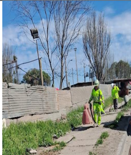
Mantenimiento de Aceras- NAPSA- km. 7+800
