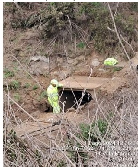
Limpieza de Alcantarilla- km. 106+860
