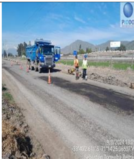
Reparación superficial de pavimentos - km. 70+000- C.S. Norte
