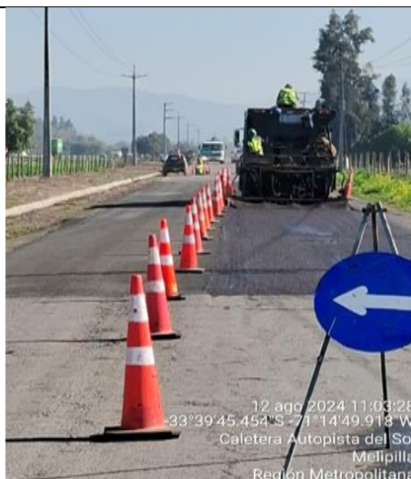
Reparación Superficial de Pavimentos (Slurry) - km. 70+800- C.S. Norte
