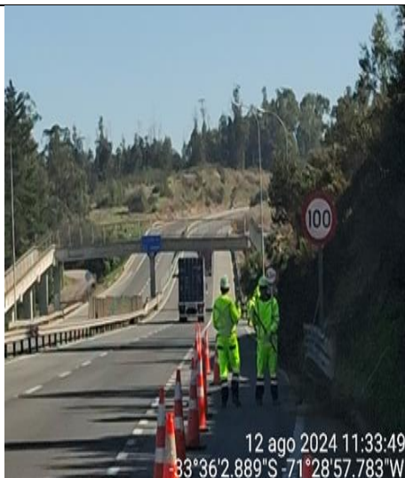
Limpieza cunetas- km. 94+800
