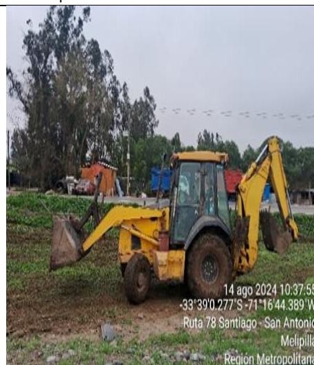
Roce Mecanizado- km. 74+260- Ascendente
