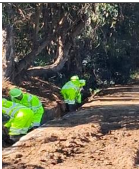
Limpieza cunetas/ Fosos- km. 97+300 CS Sur
