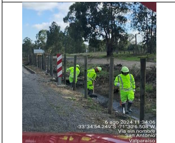
Limpieza de fosos-km. 97+700 C.S. Descendente
