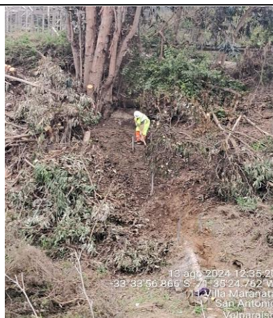
Limpieza de Bajada de agua-G-82- km.106+860
