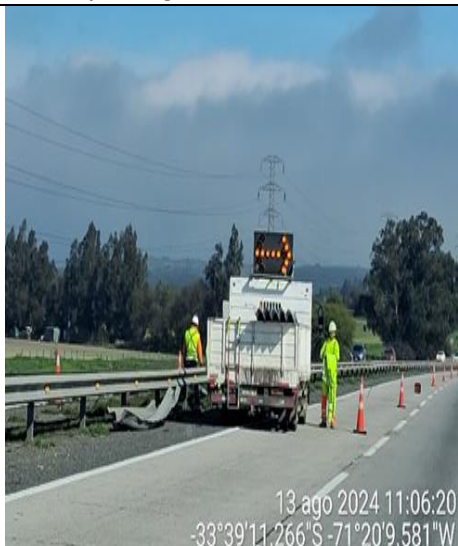
Reparación de barreras- km. 79+650 Mediana
