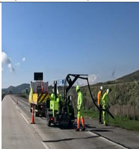
Sello de Grietas- km. 88+700
