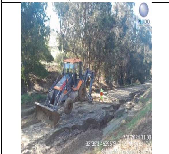
Reperfilado Simple- km. 97+400 C.S. Norte
