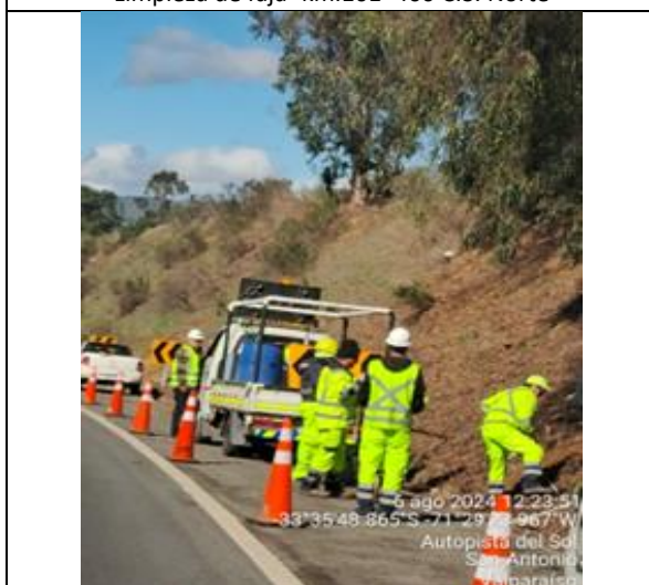
Mejoramiento seguridad Vial Cuesta El Tordo (instalación de chevrones)-km.95+700 descendente
