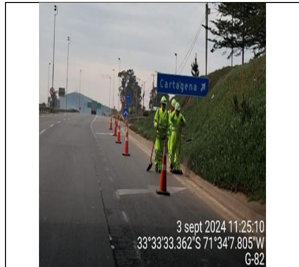
Limpieza de soleras-km.104+500 E. Aguas Buenas
