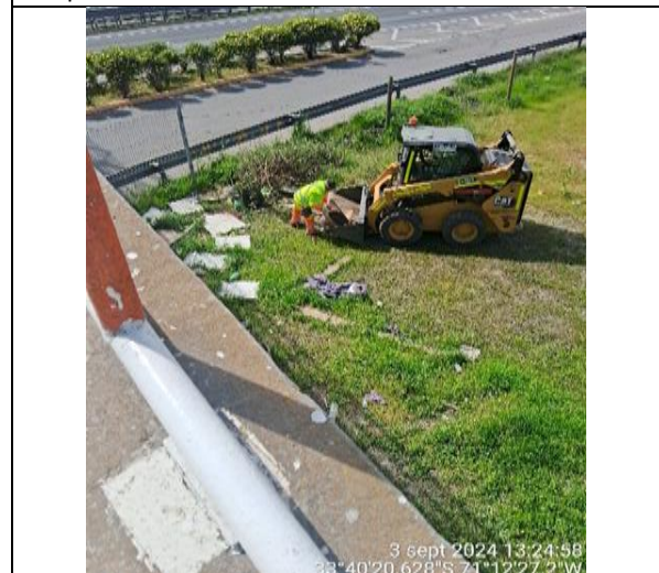
Limpieza de faja-km.66+650 descendente
