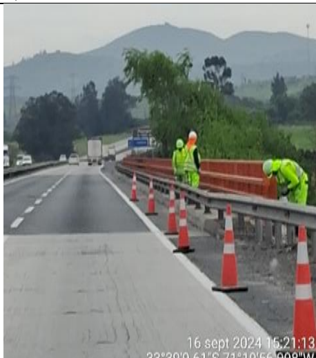
Pintura de Barandas Puente Puangue- km. 79+300- Ascendente
