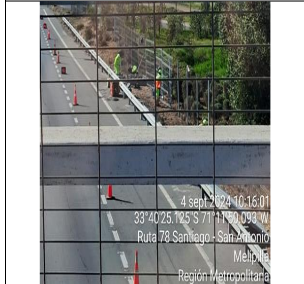
Reparación Vallas Peatonales km. 65+600 Descendente
