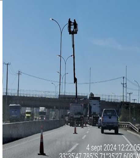
Mantención Luminarias km. 4+800 NAPSA
