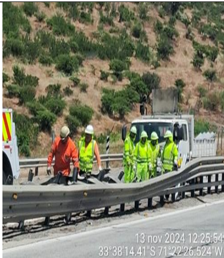
Reposición Defensas Triple onda km. 87+750 Mediana
