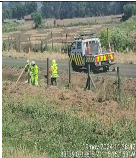
Reparación de cercos km. 73+500
