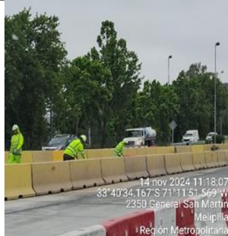
Demolición peajes Melipilla 2-3 km.65+700 -Mediana
