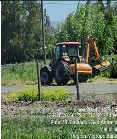
Roce con Tractor Desbrozador -km. 69+000
