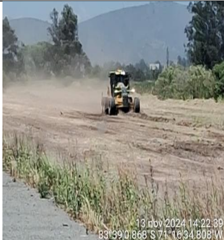
Roce mecanizado -km. 74+000
