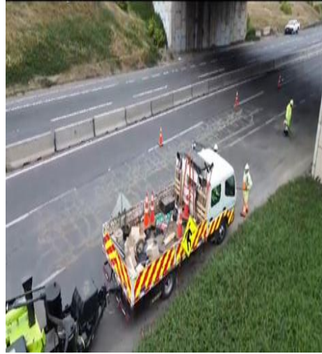
Sello de grietas Km. 6+600- NAPSA
