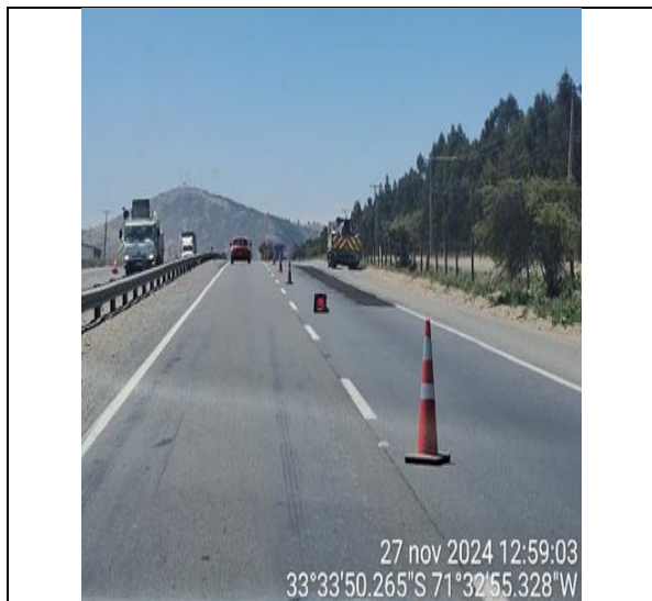
Mantenimiento de pavimento km.102+520
