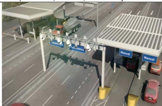
Maqueta Virtual, Ruta F-20, Pórtico telepeaje Free Flow y Caseta de Cobro Manual, Dm 6.500
