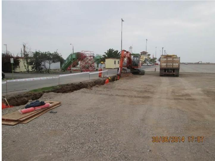
Foto N°07 Trabajos excavación Red Húmeda.
