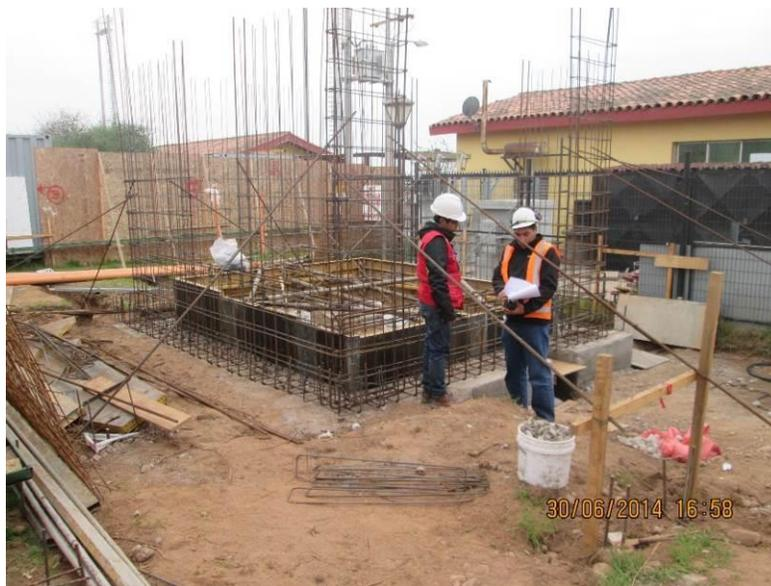
Foto N°12 Trabajos en Sub estación eléctrica de SC.
