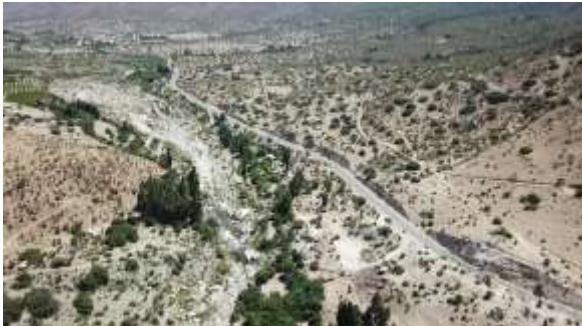
Vista de la zona del muro principal y aguas abajo del embalse
