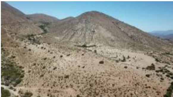
Vista de la zona del evacuador de crecidas
