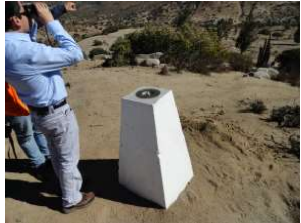
Monolito de triangulación topográfica del embalse
