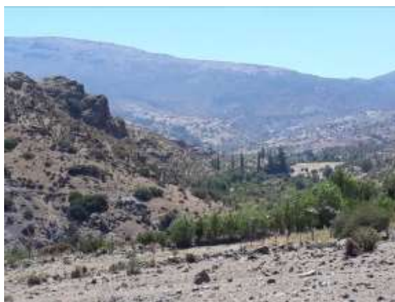
Vista de la zona de inundación o cubeta
