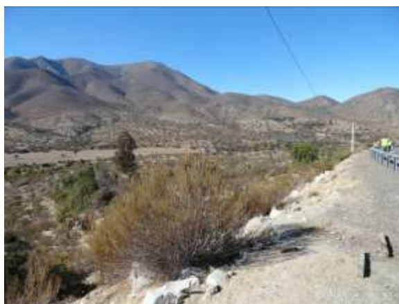
Vista inicio de variante camino E-37-D y zona de inundación
