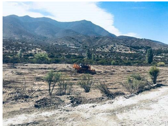
Trabajos de movimiento de material en zona donde se instalara planta de hormigon
