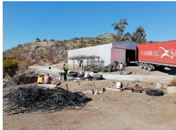
Sector Zona Planta de hormigón y áridos
