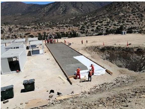
Detalle del tamaño de radier hormigonado para Edificio 2 Instalación de Faenas.
