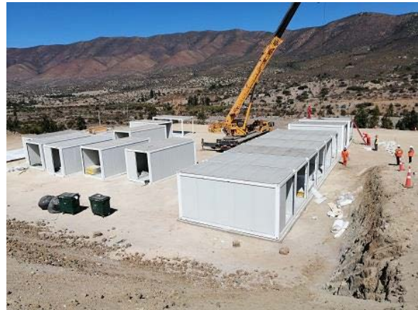
Primeros módulos de oficina prefabricada.
