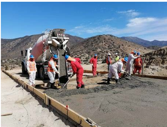
Primeras faenas de hormigonado de radier para edificios de oficina.
