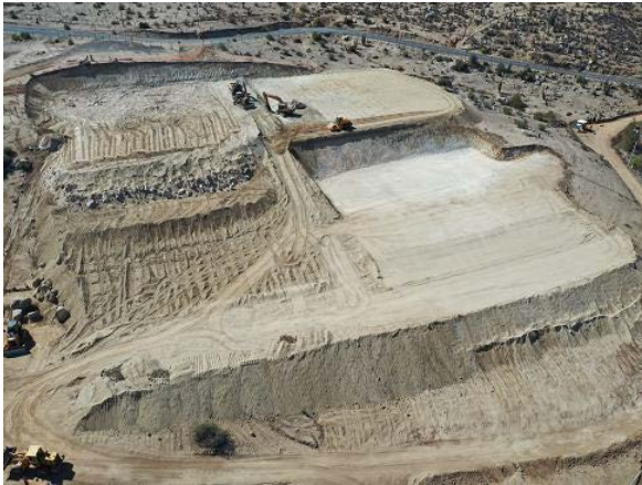
Imagen aérea donde se muestran los trabajos de excavación y rellenos en zona Instalación de Faenas.
