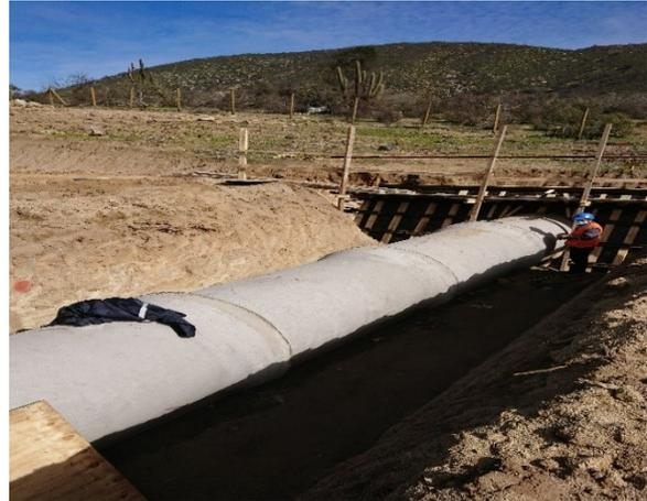
Ruta E-377D Desmolde en OA-4 Muro de Boca de Salida
