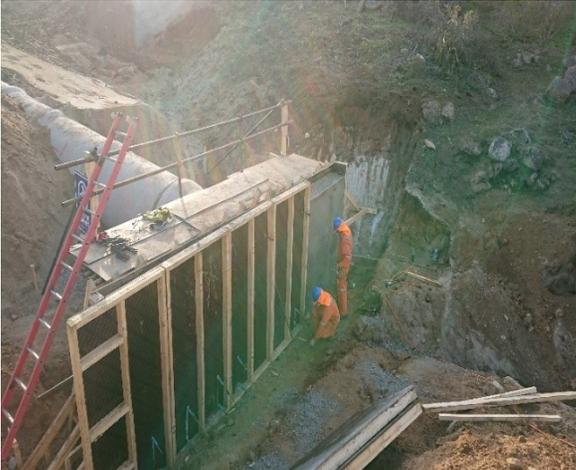
Ruta E-377D Hormigón OA-4 Muro de Boca de Salida
