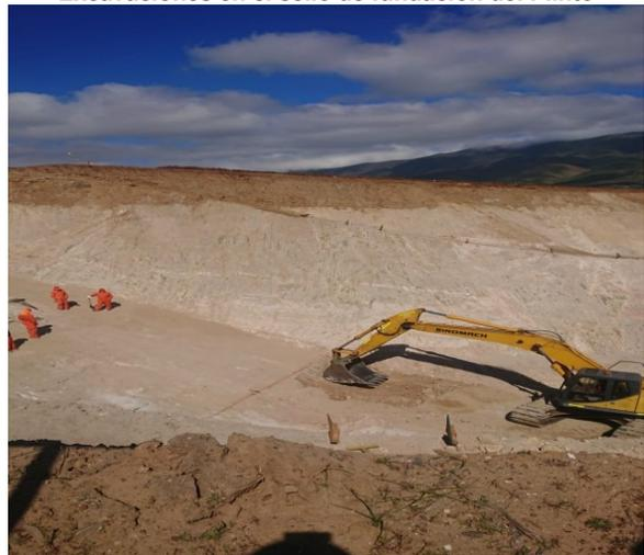
**Portal de Entrada Túnel de Desvío: Al fondo se aprecia la faena de inyección de pernos.**
