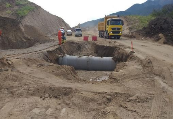
Recompactacion de Relleno estructural OA-8 Ruta E-377
