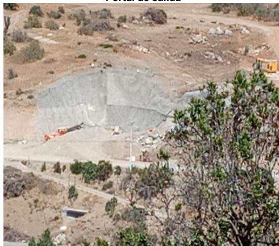
Portal de entrada, perforación tronadura
