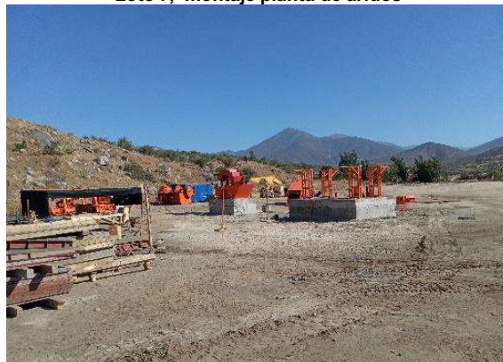
Lote 7, montaje planta de áridos
