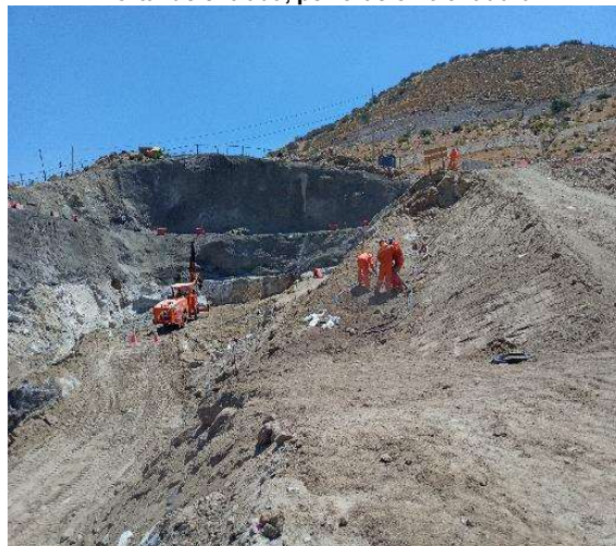
Portal de entrada, perforación tronadura
