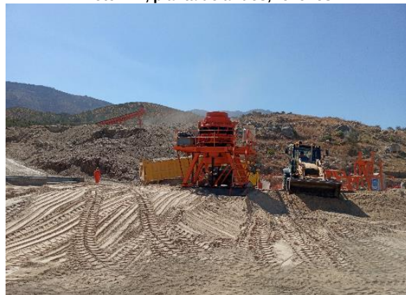
Lote N°7, planta de áridos, rellenos
