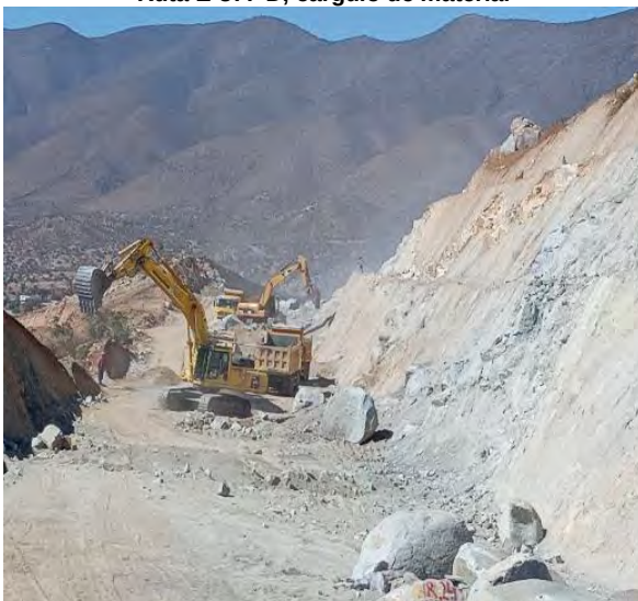
Instalación de faenas, pantallas acústicas
