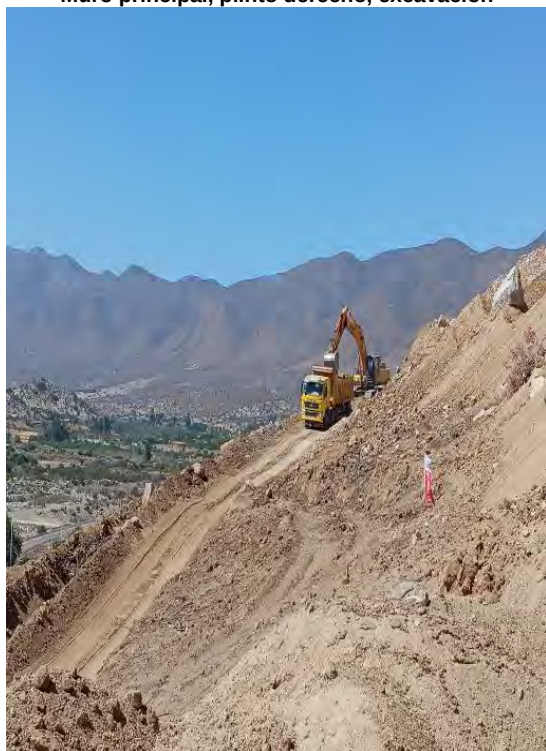
Muro principal, plinto derecho, excavación
