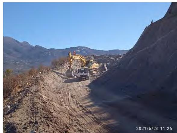
**Ruta E-377 D, colocación de subbase**
