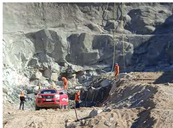
Portal de salida de Túnel
