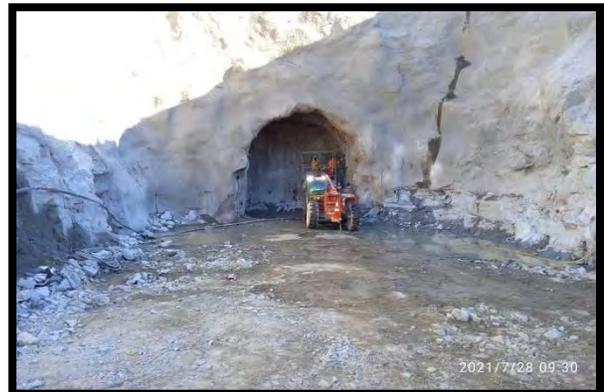
FIG N°4: Portal de Entrada Túnel de Desvío.
