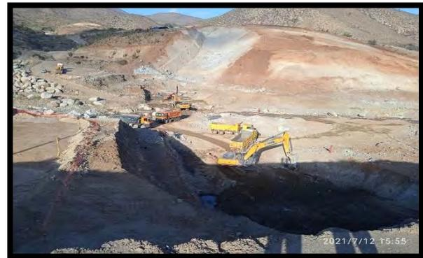
FIG N°3: Muro Principal. Plinto Lateral Derecho (Oeste)
