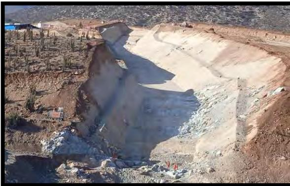
FIG N°7: Portal de salida. Colocación de Planchuelas
