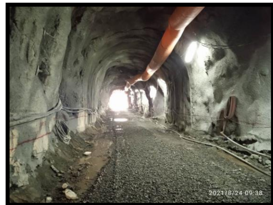
FIG N°6: Vista General Túnel de Desvío
