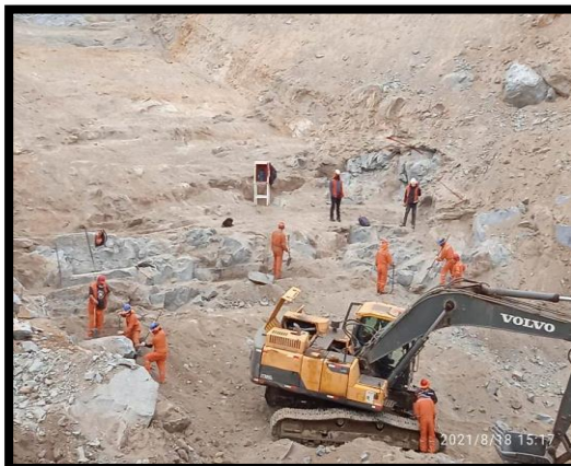
FIG N°5: Muro Principal – Plinto Izquierdo. Limpieza Manual y Mecánica
