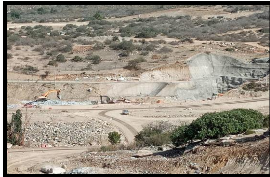
FIG. N°2: Vista General Túnel de Desvío – Portal Salida
