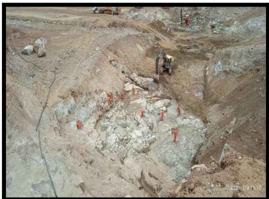
FIG N°5: Muro Principal – Plinto Valle. Limpieza Manual y Mecánica
