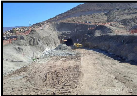
FIG N°4: Túnel de Desvío – Vista General Portal Entrada
