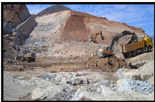
FIG N°5: Muro Principal – Plinto Valle. Limpieza Manual y Mecánica
