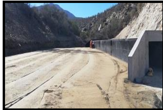
FIG N°12: Ruta E-377D. Compactación Base Granular
