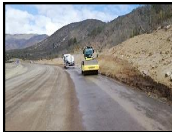
FIG N°12: Ruta E-377D. Compactación Base Granular
