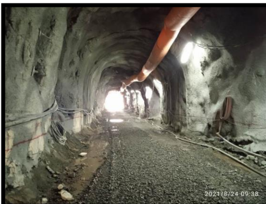
FIG N°6: Vista General Túnel de Desvío
