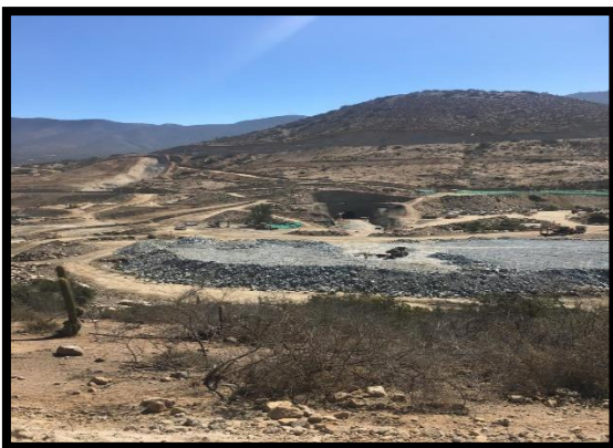
FIG N°5: Vista General Ataguía y Portal Entrada Túnel de Desvío
