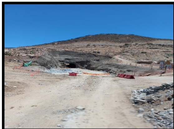
FIG N°6: Vista General Túnel de Desvío – Portal Entrada
