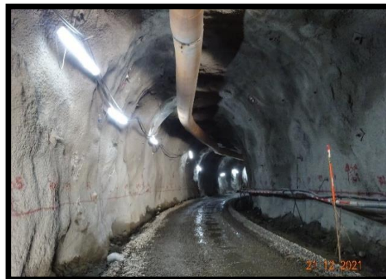
FIG N°3: Vista General Túnel de Desvío - Portal Salida
