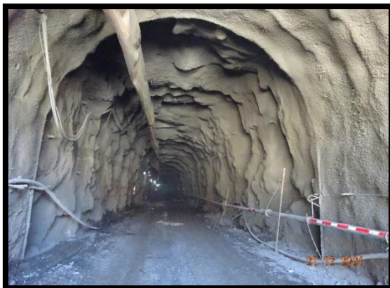
FIG N°8: Vista General Túnel de Desvío – Portal Entrada
