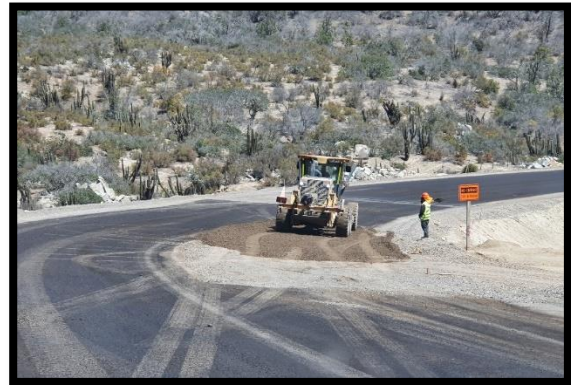
FIG N°9: Ruta E-377D – Aplicación de Emulsión CRS-2
