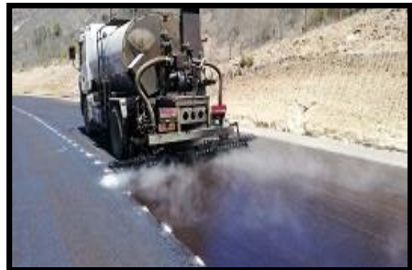
FIG N°9: Ruta E-377D – Aplicación de Emulsión CRS-2
