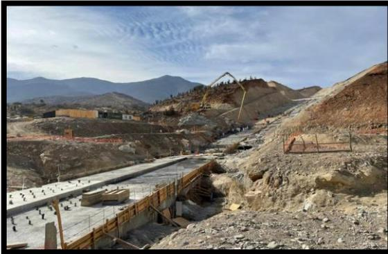
**FIG. N°2: Plinto Valle – Instalación de Moldajes y Limpieza de Roca**
