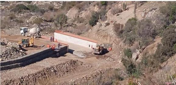
FIG N°8: Acopio material de Relleno en Estación Fluviométrica Frutillar
