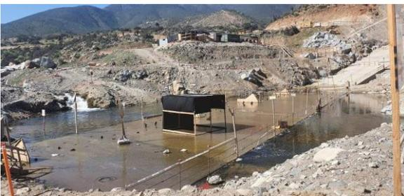
FIG N°5: Hormigón Reposición sobreexcavaciones Túnel de Desvío
