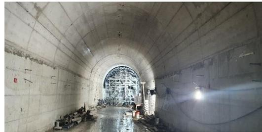
Fig. 4, Juntas dilatación túnel desvío
