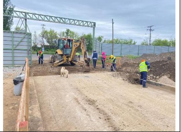
Figura N°11: excavaciones masivas
