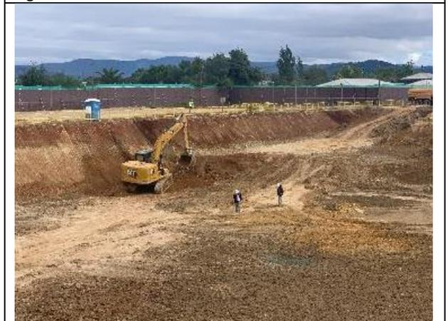
Figura N°4: excavaciones masivas
