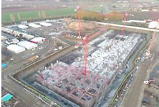
Hormigón de fundación
