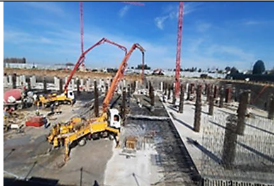
Trabajos enfierradura de fundación
