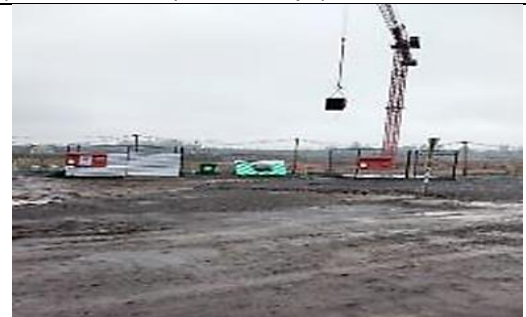
Implementación de patio salvataje para control de residuos
