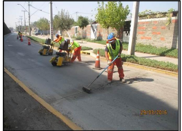
**Retiro de sello en mal estado en pavimentos de hormigón, para posterior sellado.**
