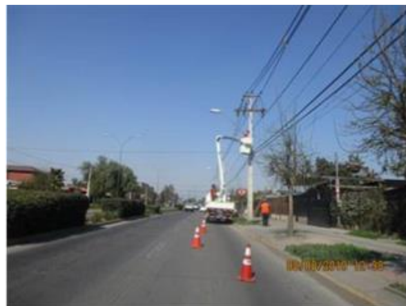
Mantención de luminarias
