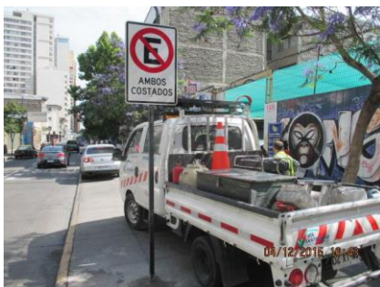
Reposición de señal vertical
