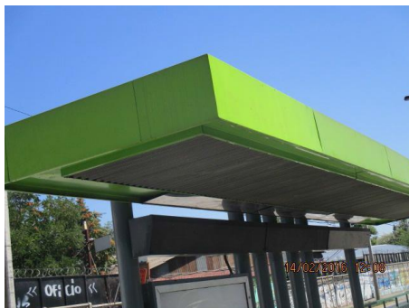
Reposición de pintura en paradero de tramo 2
