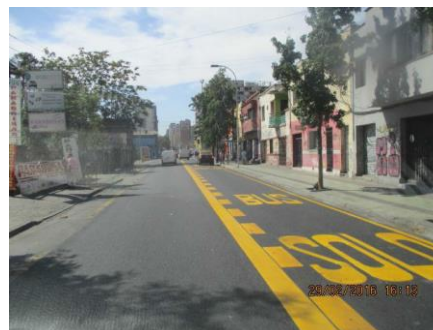
Mantención de demarcación tramo 1
