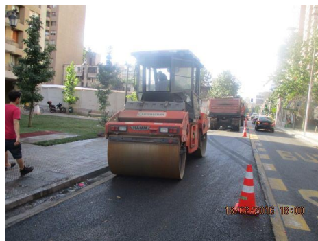
Recapado asfáltico en tramo 1
