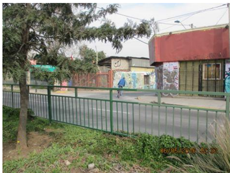
Reposición de pintura en valla peatonal
