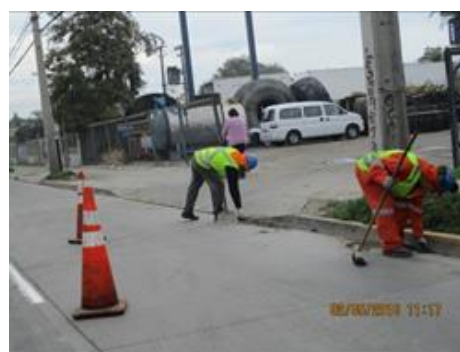
Mantención de pavimento
