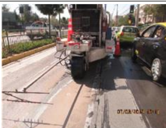
Cepillado de pavimentos
