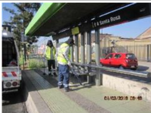
Mantenimiento de refugios peatonales
