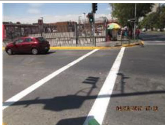
Reparación de demarcación horizontal
