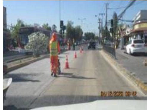
Aplicación de sello de alta fricción en pavimento
