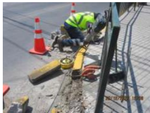
Reparación de soleras
