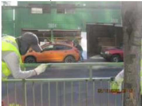
Mantenión de pintura de estructuras metálicas.
