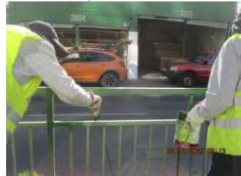
Mantenión de pintura de estructuras metálicas.
