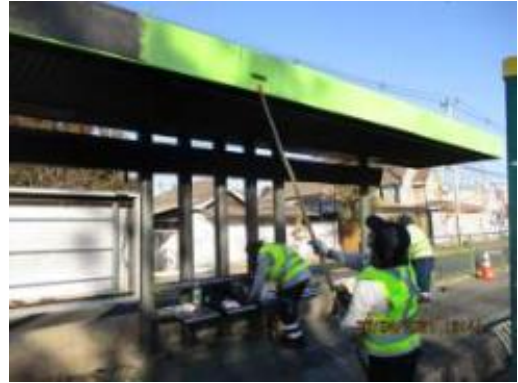
Mantenimiento de pintura de paraderos
