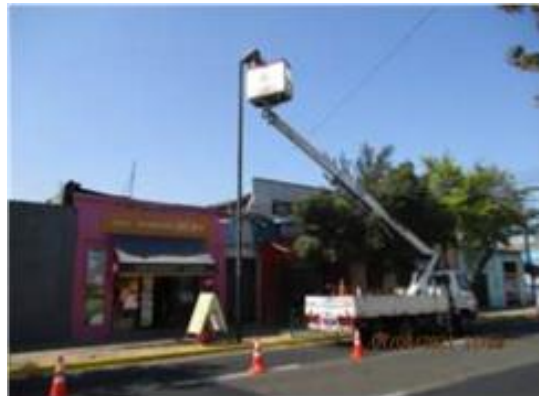
Mantenimiento de luminarias
