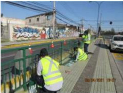
Mantenimiento de pintura de vallas
