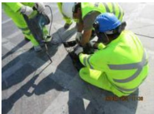
Reparación de pavimentos
