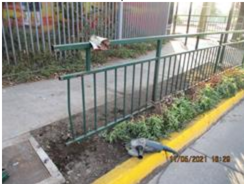
Mantenimiento de pintura de vallas
