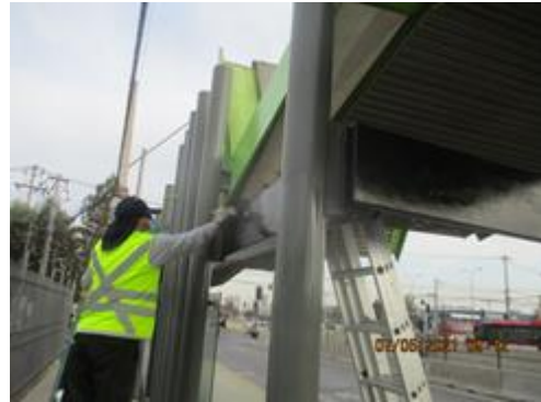
Mantenimiento de pintura de paraderos
