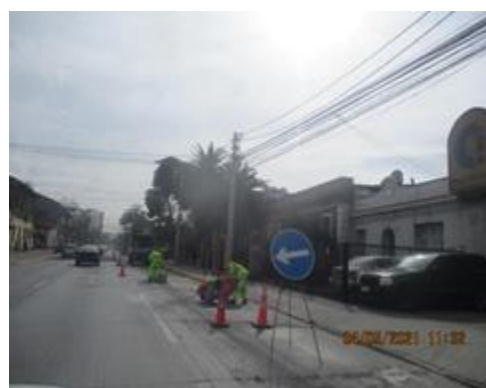
Mantenimiento y reparación de pavimentos
