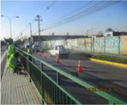
Mantenimiento de pintura de vallas
