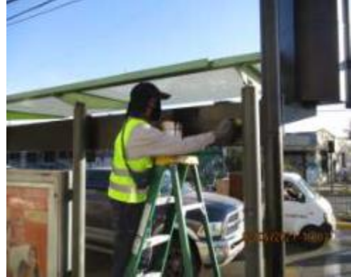
Mantenimiento de pintura de paraderos
