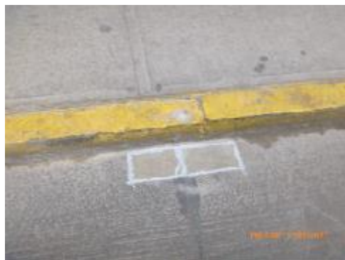
Mantenimiento y reparación de pavimentos
