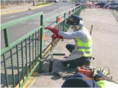
Mantenimiento de pintura de vallas
