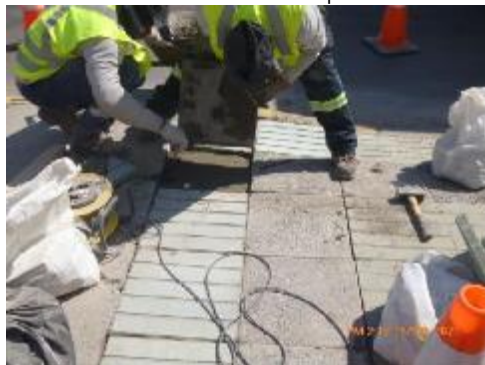
Mantenimiento de baldosas en paraderos
