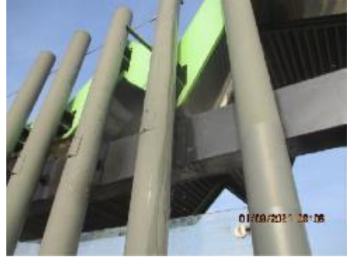
Mantenimiento de pintura de paraderos
