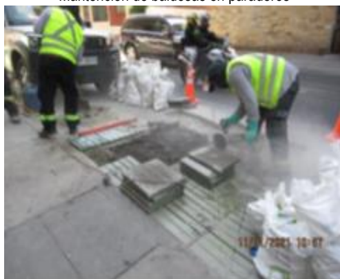
Mantenimiento de baldosas en paraderos
