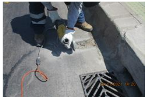
Mantenimiento y reparación de pavimentos
