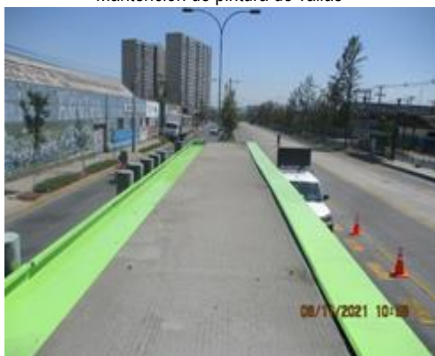
Mantenimiento de pintura de vallas
