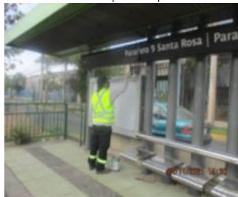
Mantenimiento de pintura de paraderos
