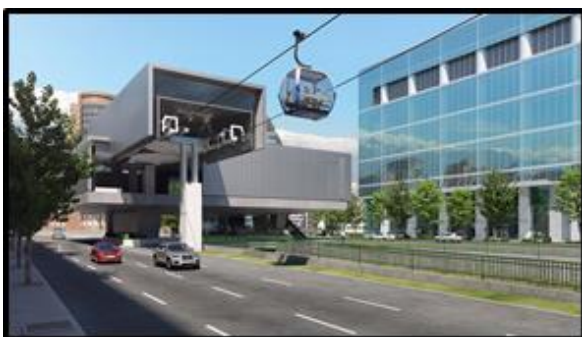
Estación sobre canal San Carlos
