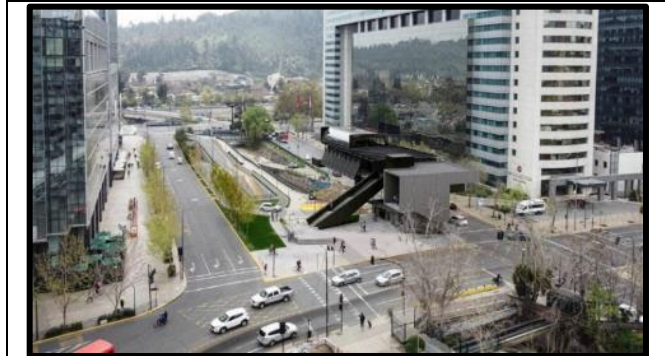
Estación Canal San Carlos
