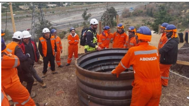
Trabajos de SAESA en Parque Metropolitano
