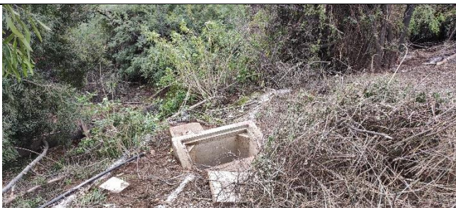
Trazado de Tuberías Sector Pila 9
