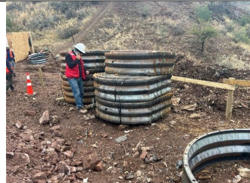
Trabajos de SAESA en Parque Metropolitano
