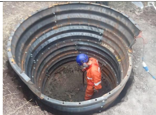
Trabajos de SAESA en Parque Metropolitano
