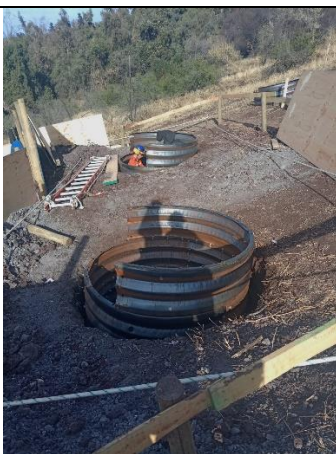
Trabajos de SAESA en Parque Metropolitano
