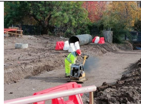
Compactación Capas Finales de AALL
