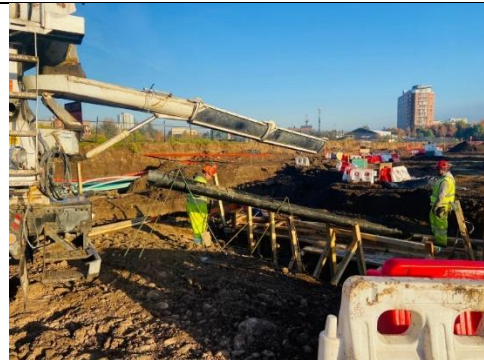
Hormigonado de Muro Boca AALL
