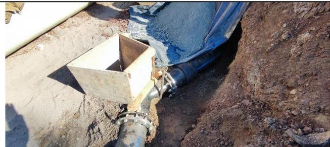
Encofrado para machón de anclaje tubería HDPE Pila 9 - PMET
