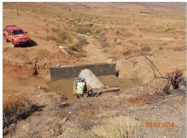
Imagen N°12. Relleno Tubos de hormigón
