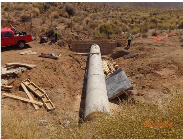
Imagen N°11. Instalación Tubos de hormigón
