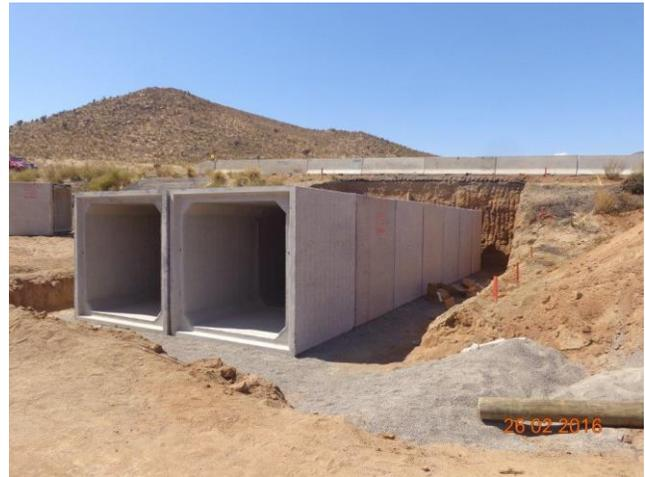
Imagen N°08. Instalación Cajones prefabricados
