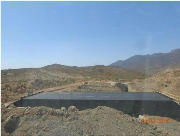
Imagen N°07. Impermeabilización Cajón Prefabricado
