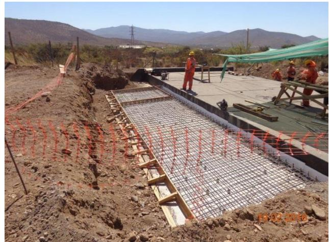
Imagen N°10. Construcción Losas de Acceso OA
