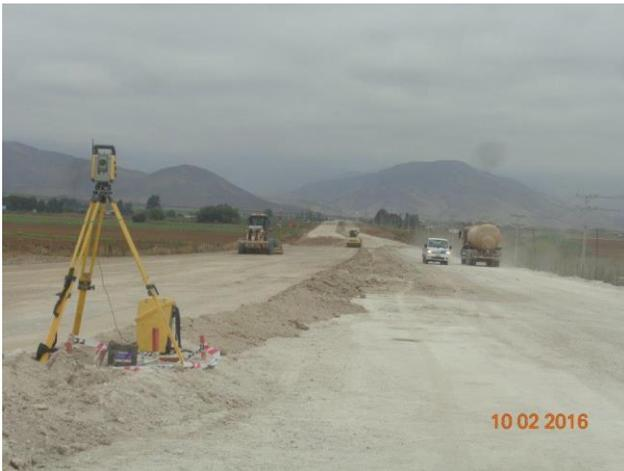
Imagen N°09. Preparación de Sub Rasante Tramo 2
