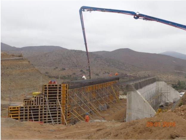
Imagen N°01. Hormigonado Atravesio El Totoral
