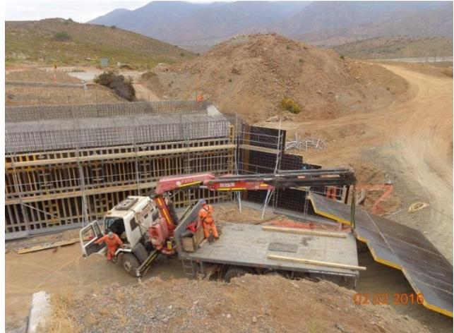
Imagen N°02. Instalación Moldaje Atravesio El Totoral
