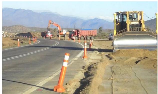
Imagen N°05. Trabajos terraplén Pista Izquierda Dm 23.400
